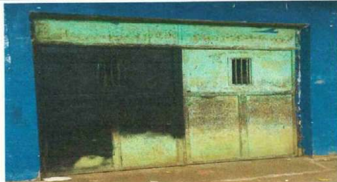
Foto 2: Sustrucción de un portón .
